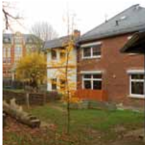
Garten und Seitenansicht des Evang. Kindergartens in Schleiz - Dank Unterstützung der Arenberg-Stiftung konnte dort vieles saniert werden.
