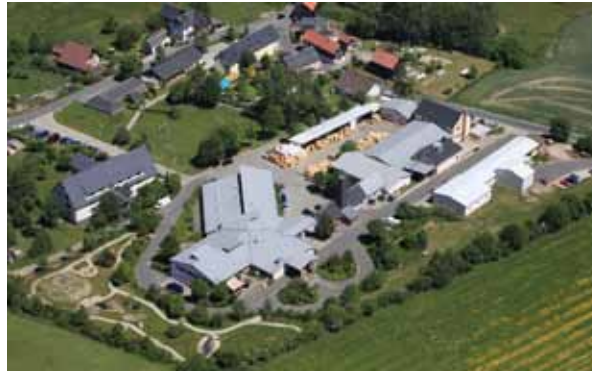
Wohn- und Werkstätten Christopherushof in Altengesees
